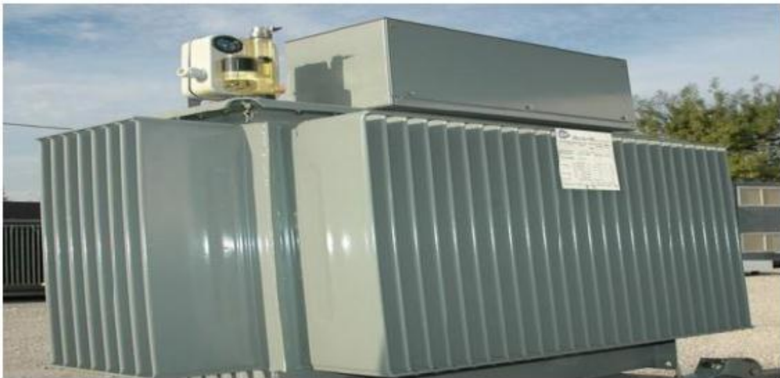
Figure 1.6 : La cuve d'un transformateur de puissance.
