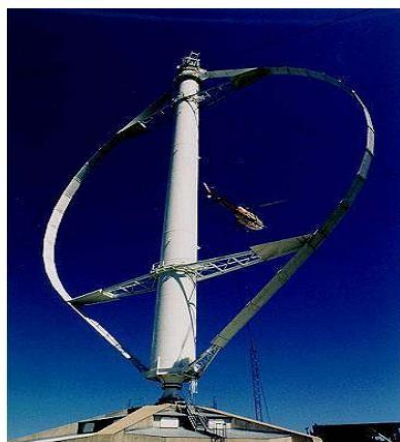
Figure I-16 : Eolienne à axe vertical (structure de Darrieus)
