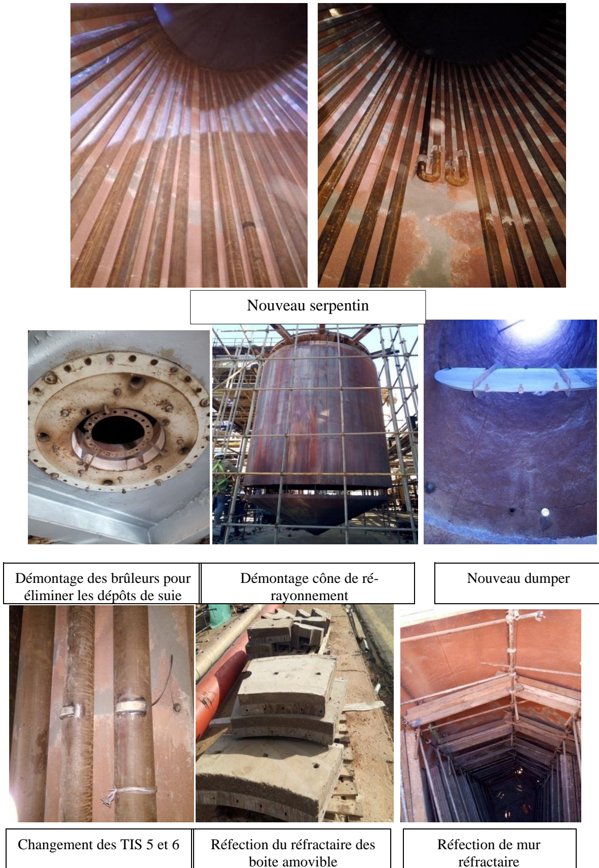
Figure VI.14. Rénovation du four 21F1.
