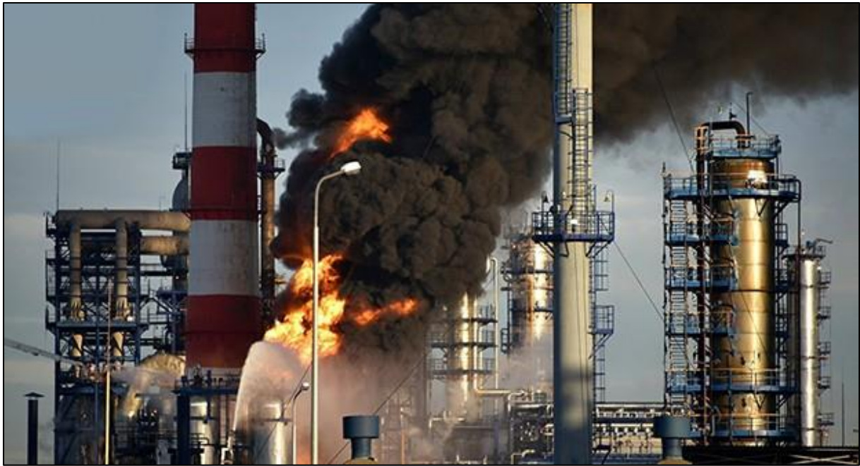
Figure II.10. Explosion à l'unité 100 de la raffinerie de Skikda [41]
