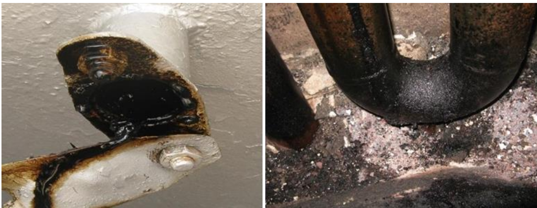
Figure VI.3. Présence de produit noir sur les guides de gaines du tube N°17
