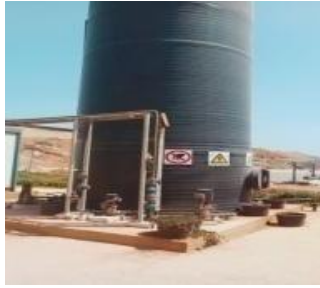
صورة (31):تمثل المرحلة (2):خزان تجميع وترشيح العصارة
