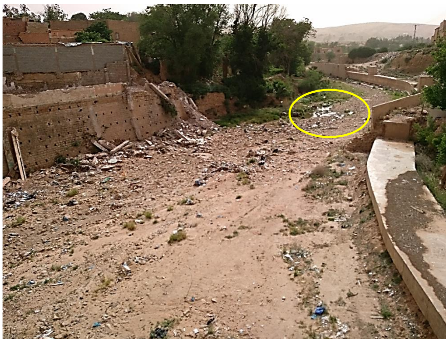
Figure 33 : Fuite d'eau usée à partir du canal au niveau de l'oued Deffa
