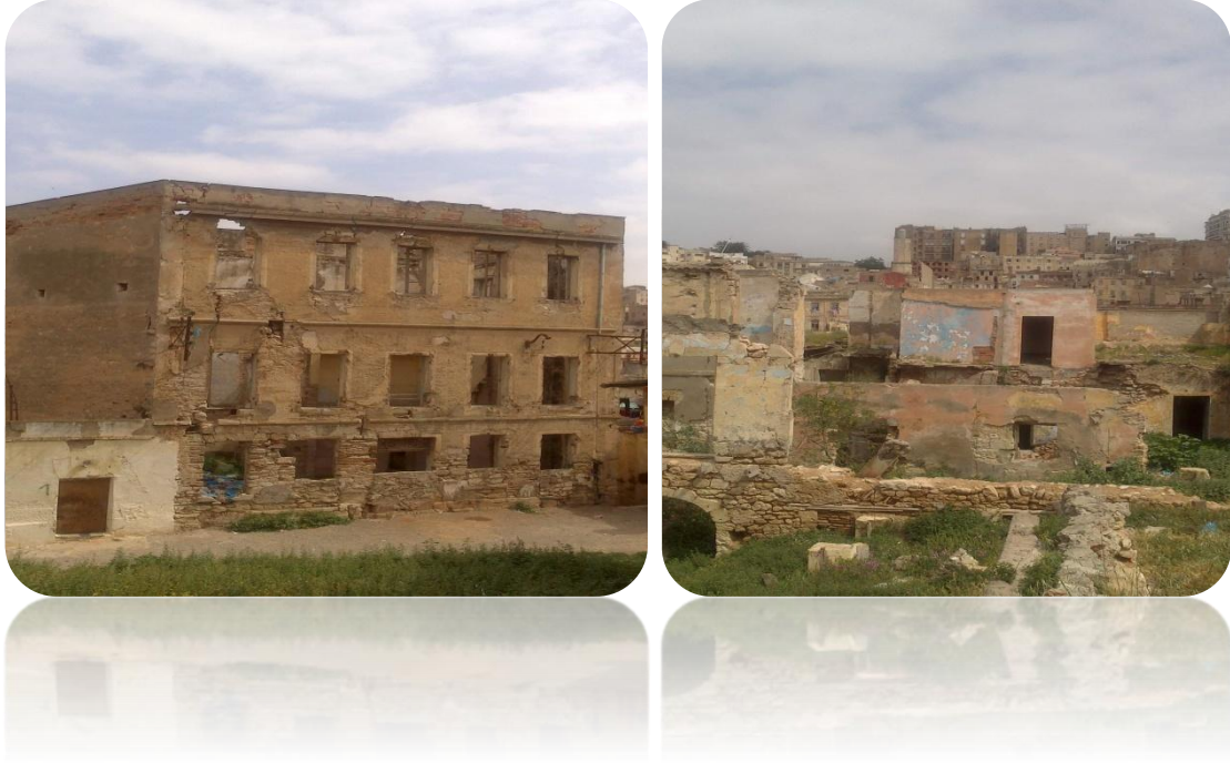
الصورة 29; 30: انهيار مستشفى العسكري بحي سيد الهواري
