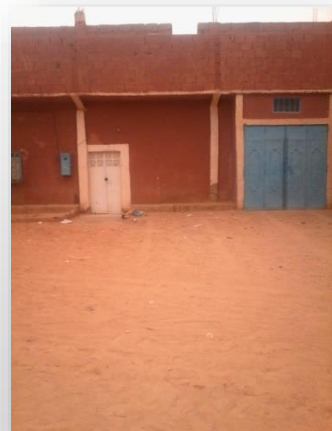
الصورة رقم 2: طابق أرضي
