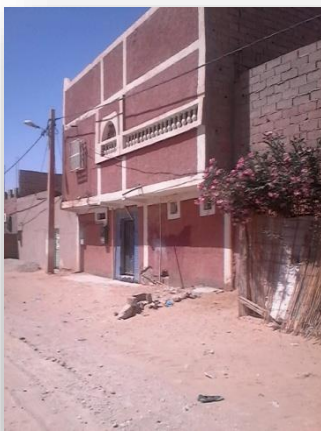
الصورة رقم 3 : طابق أرضي+1
