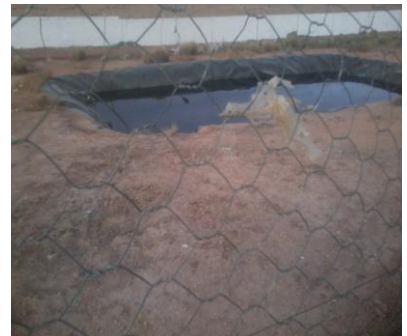
الصورة رقم (22) حفرة التطهير
