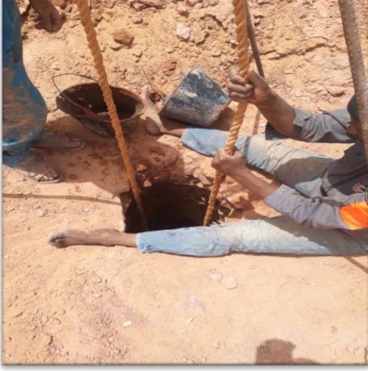
الصورة رقم 14: أشغال الصيانة لفقارة تدمام.
