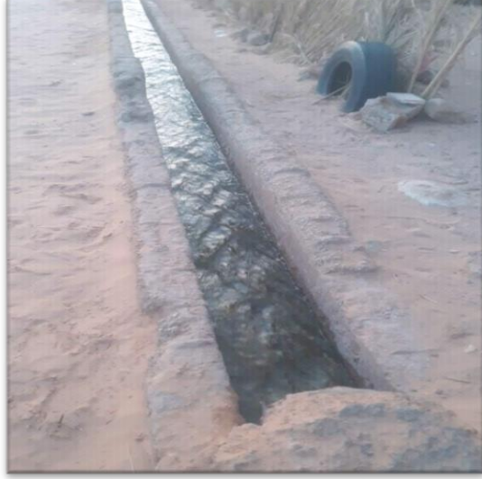
الصورة رقم 09: الساقية من الخرسانة الاسمنتية بفقارة تدمام
