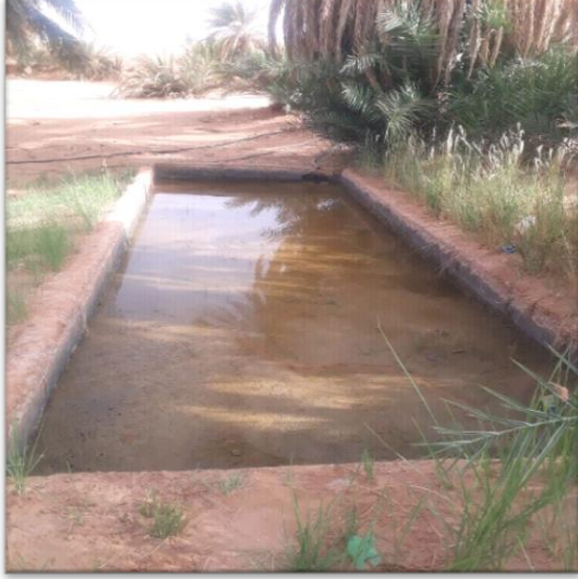
الصورة رقم 10: الماكن من الخرسانة الاسمنتية بفقارة رحو
