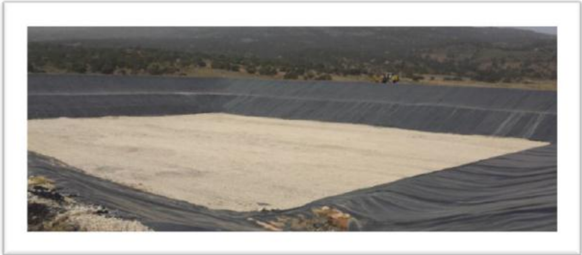
صورة رقم (08): خندق لردم النفايات
