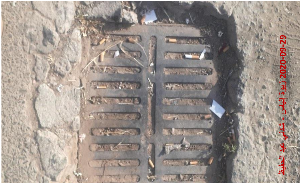
الصورة -09- حالة بالوعة الصرف الصحي في النقطة السوداء 02
