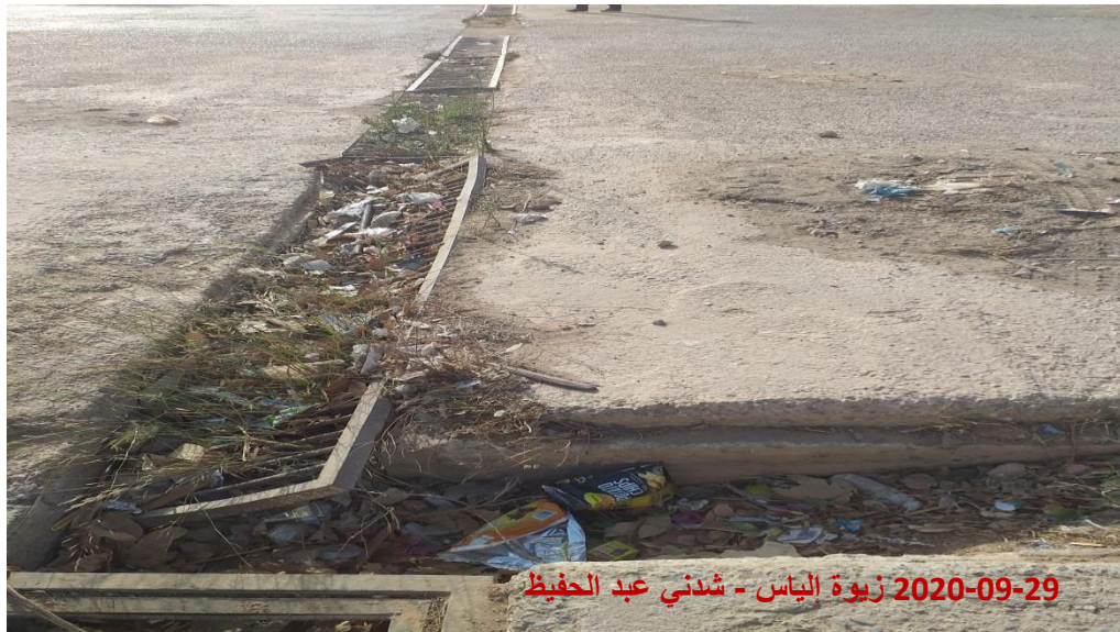
الصورة -11- حالة بالوعات الصرف الصحي في النقطة السوداء 03
