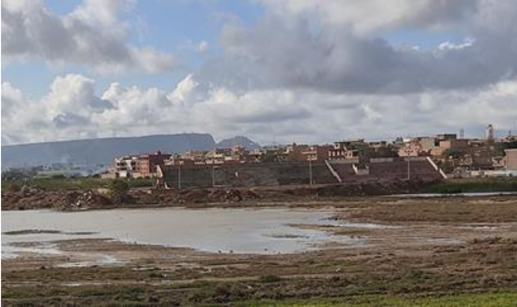
الصورة ( 20) : الملعب الجوارى بعدما غمرته المياه - حي النجمة.
