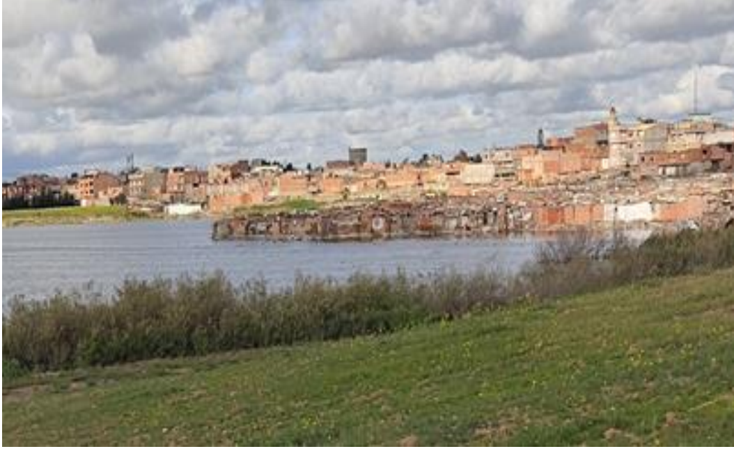
الصورة (21) : سكنات فوضوية غمرتها المياه – سيدي الشحمي.
