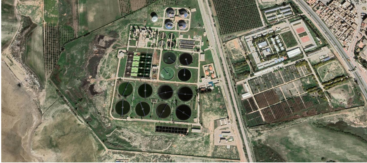
صورة رقم (06) لمحطة معالجة مياه الصرف الصحي
