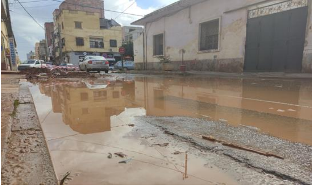
الصورة (17) : انسداد بالوعات المياه بسبب المياه الأرضية المتصاعدة و اهتراء الطرقات - الكرمة.
