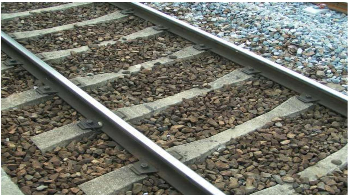
**Fig.06** Photo montrant des agrégats de basalte utilisé dans les voies ferries pour absorber la vibration
