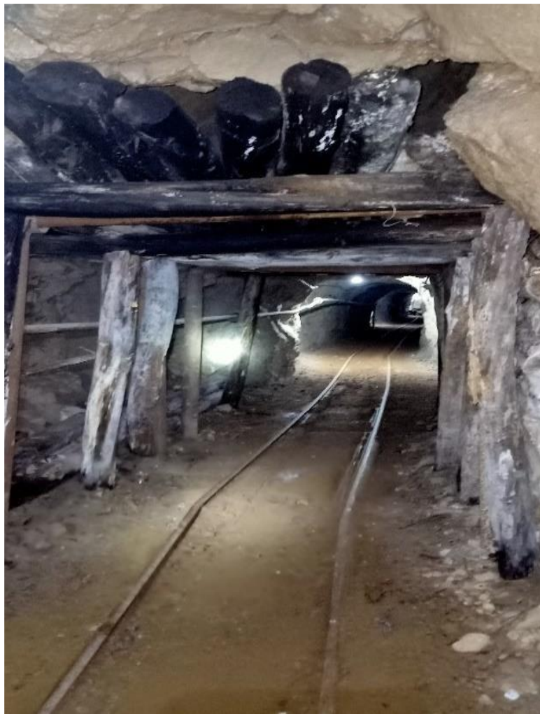
Figure 21: Soutènement dans le Gisement Lakhdar
