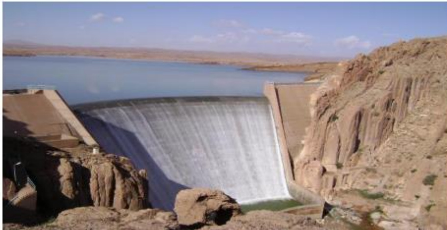
Figure N°06 : Evacuateur de crue du Barrage de Brezina
