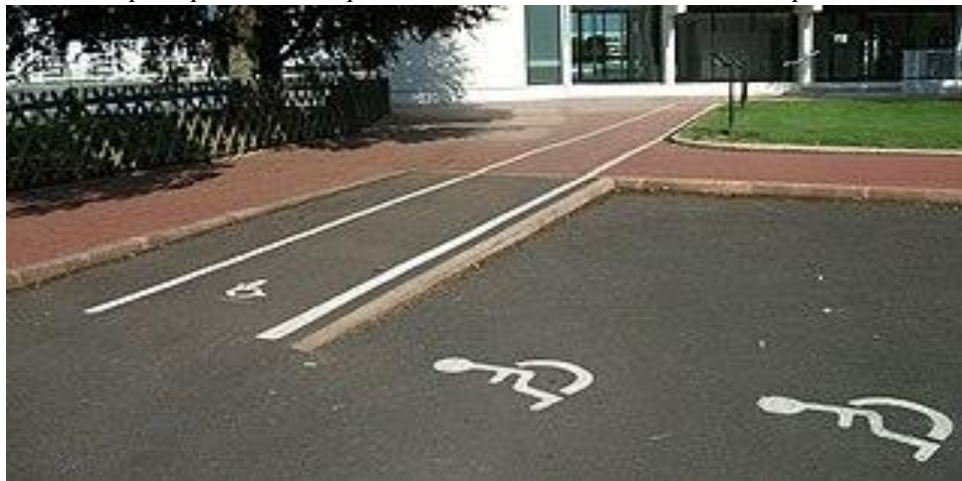
Figure36 : Accessibilité de la voirie et de l'espace public pour PMR
