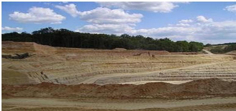
**Photo 02: Exploitation de carrière de sable (par abatage)**
