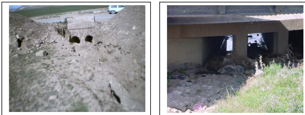
Figure II.10. Exemples des ouvrages à re-calibrer
