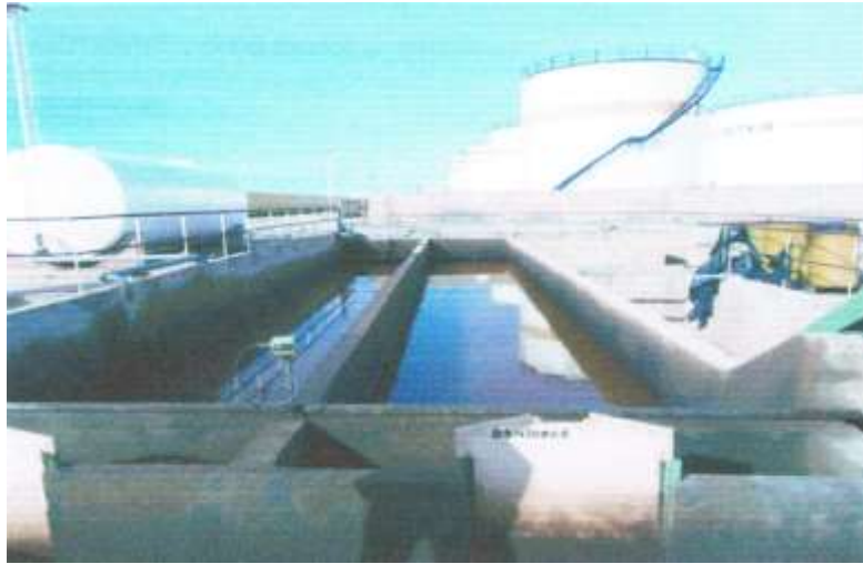
صورة توضح حوض تجميع ومعالجة النفايات السائلة على مستوى مركز تخزين الوقود بتيارات
