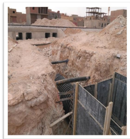
Figures 28: Ouvrage de captage sous la voie ferrée
