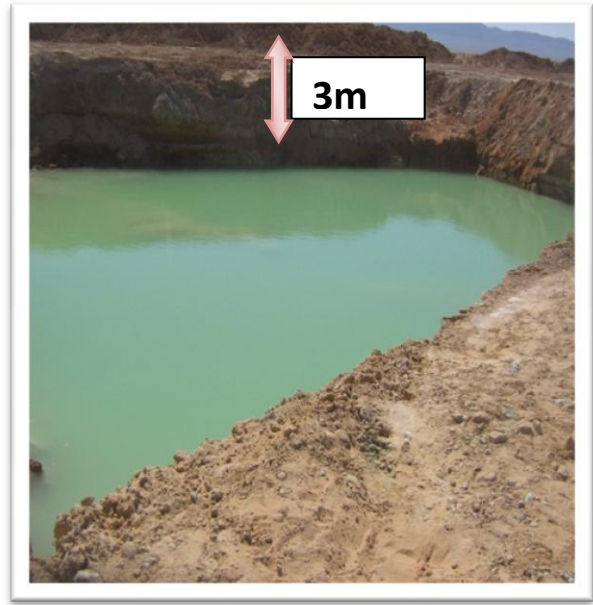
Figure 26 : L'assise de la station de relevage avant et après épuisement de la nappe phréatique
