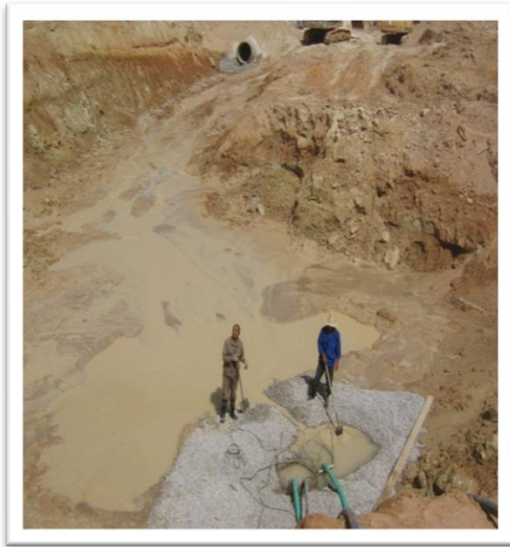
Figure 26 : L'assise de la station de relevage avant et après épuisement de la nappe phréatique
