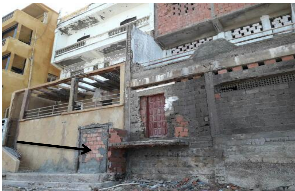
Photo 02 : Ouvrir des issues derrière les constructions et fermer ceux qui font face à la mer
