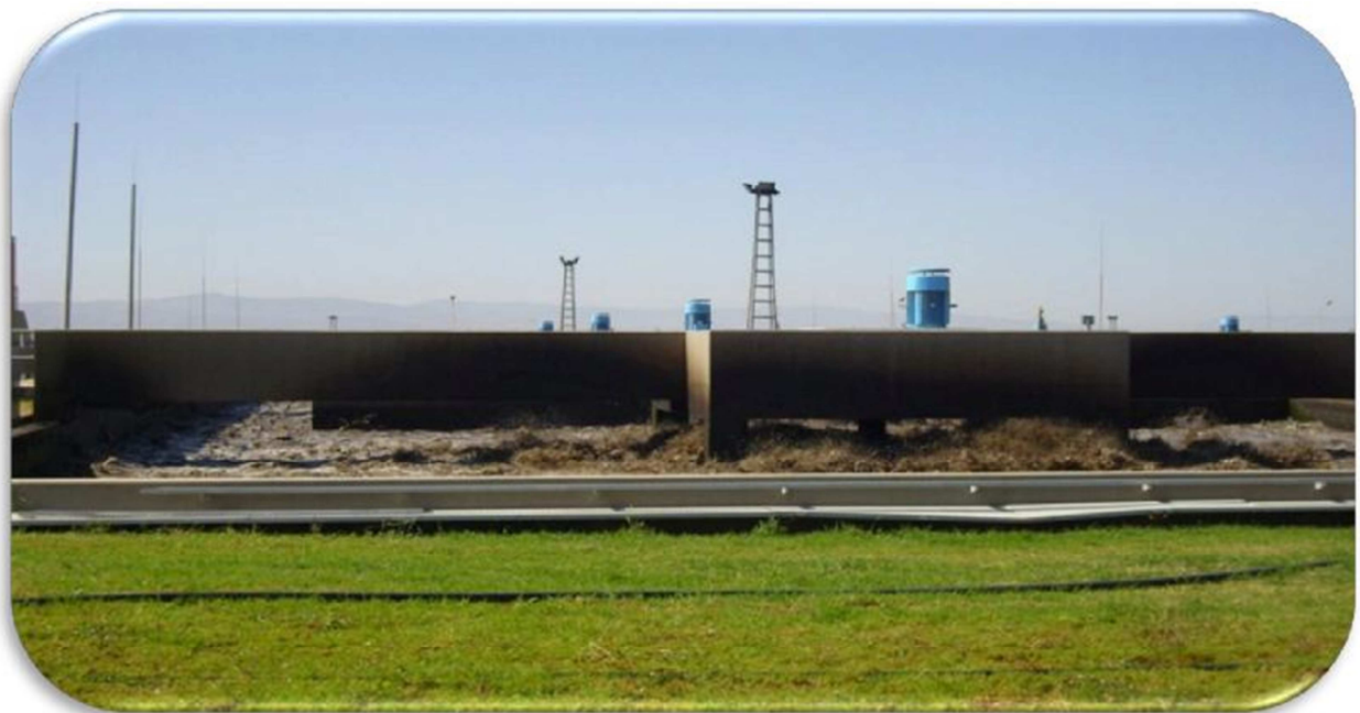
Figure 13: Poste de déversoir d'orage
