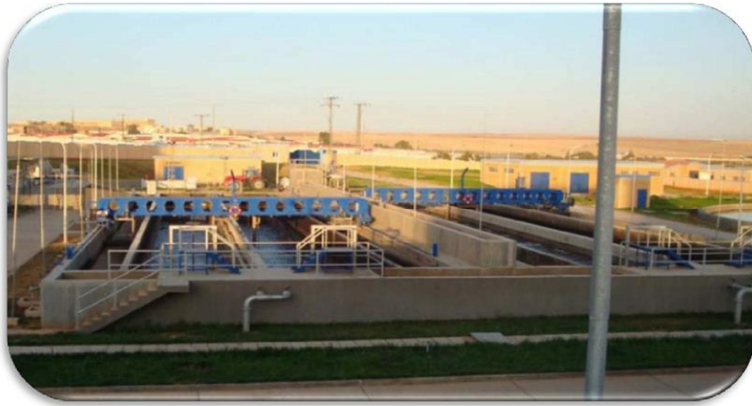
Figure 15: Dessableur déshuileur STEP d'El Kerma
