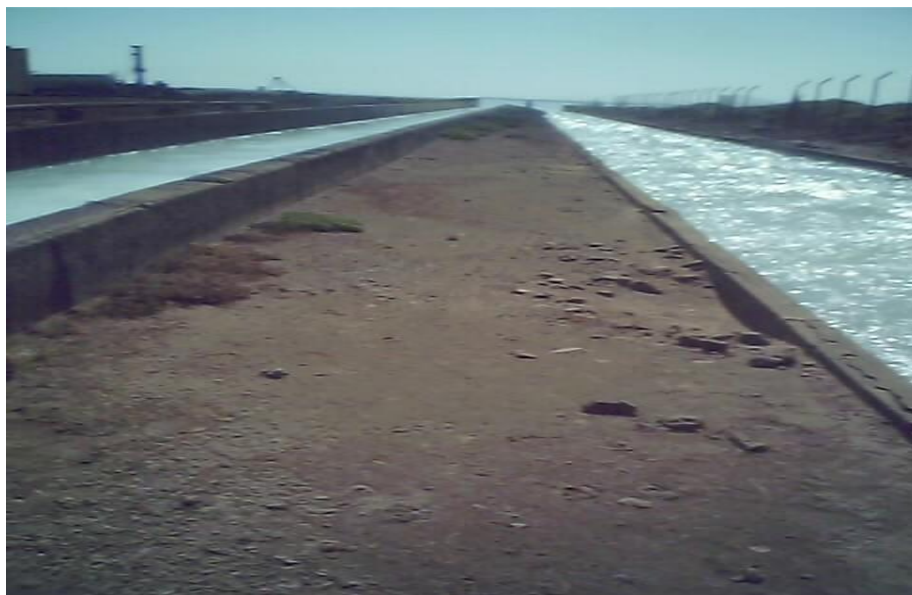
Fig n 7° :Rejets liquides de l'unité II
