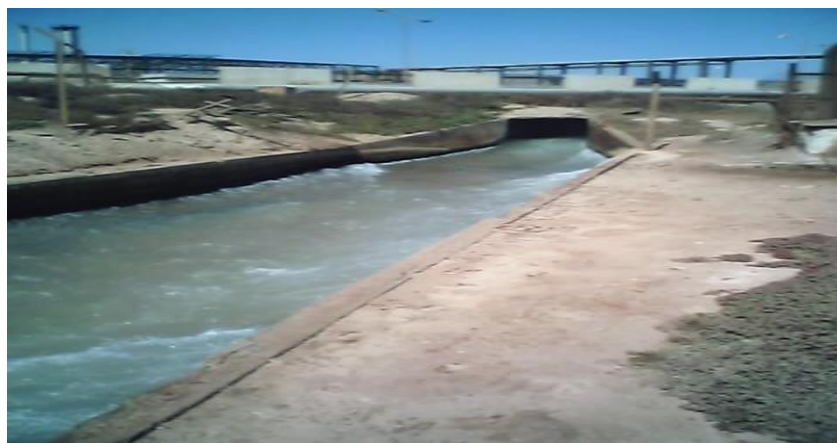
Fig n° 6 : Les rejets liquides de l'unité I
