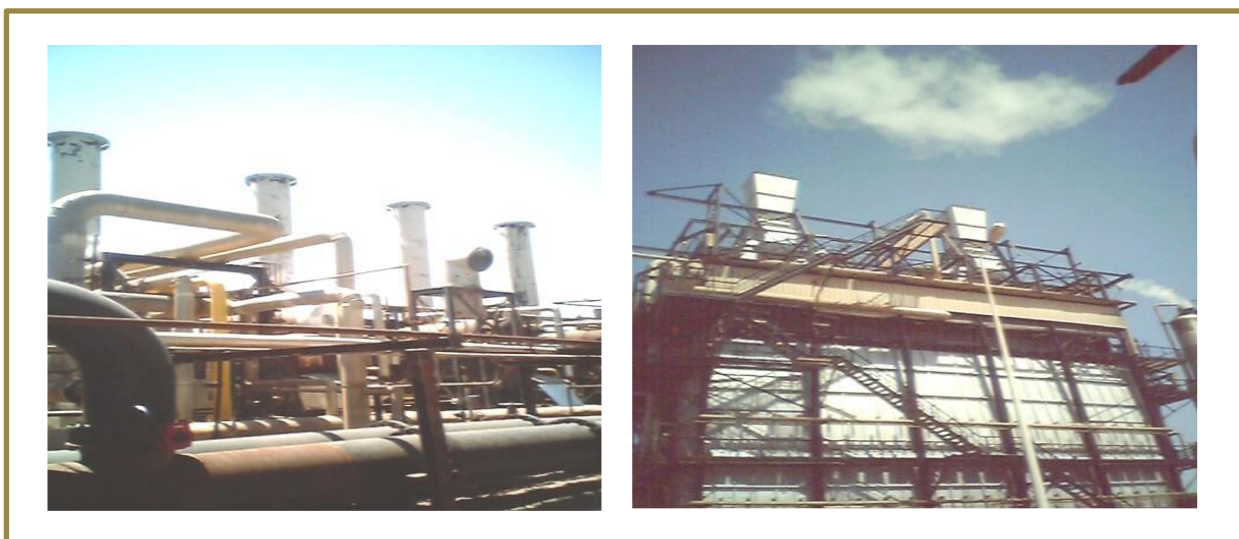
Fig n 8 : Cheminées des chaudières des utilités A et B
