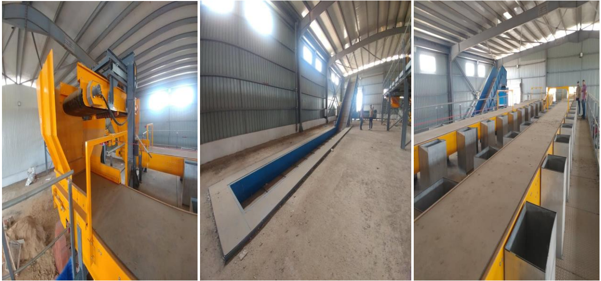
Figure 19 : Le centre de tri de CET-SBA en cours de réalisation. 16 juin 2020
