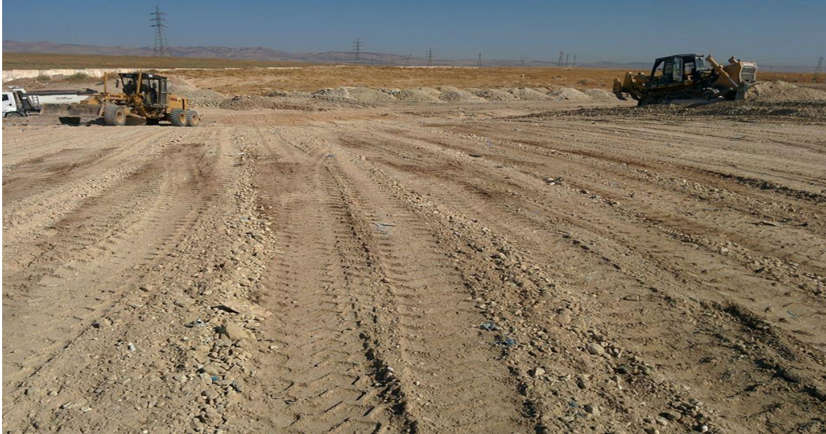
Figure 14 : bulles de trassement. 16 juin 2020
