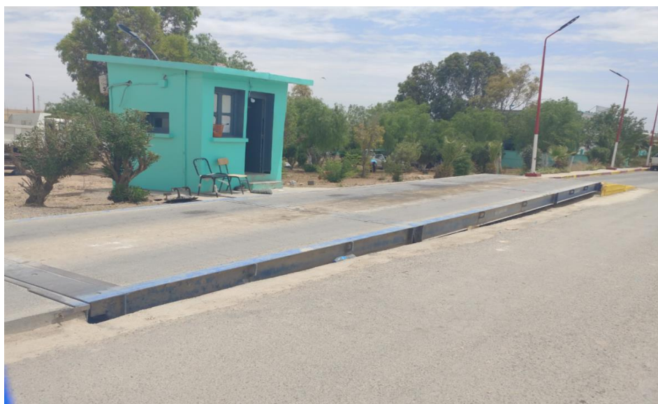
Figure 11 : pont bascule de CET de Sidi bel abbès. 16 juin 2020
