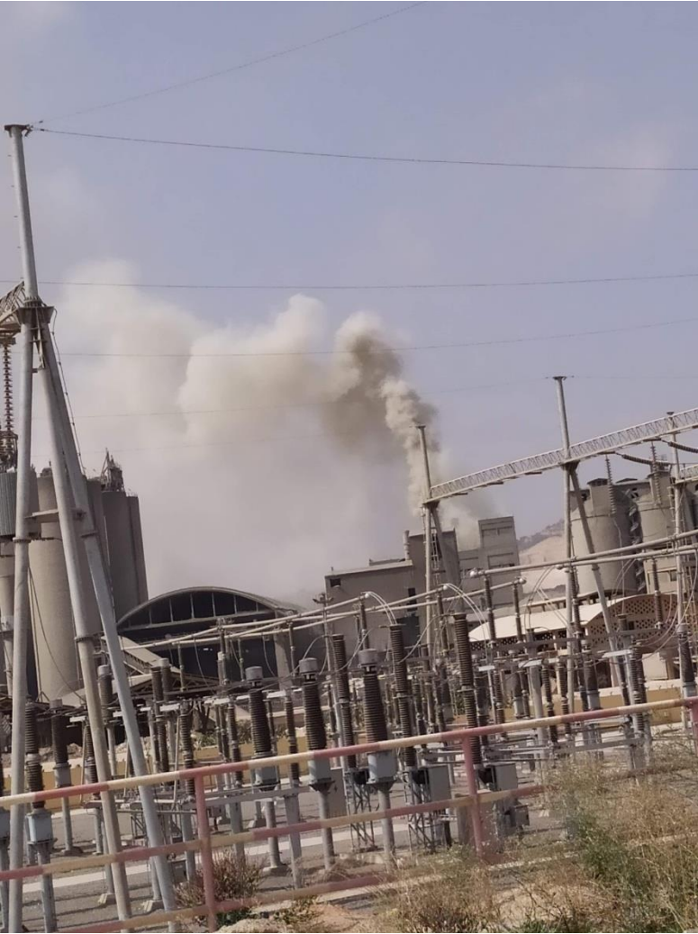
Photo N° 02 vue de déchets de la cimenterie de Zahana.
