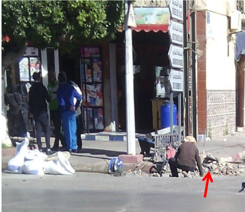
Photo N°(26) : Opération de débouché réseaux d'assainissement : centre ACL
