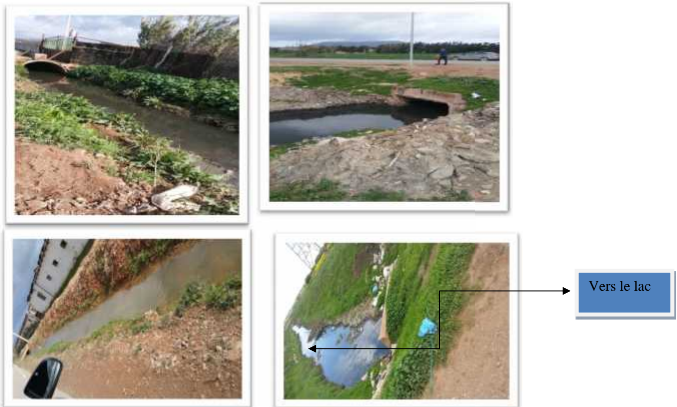
Fig n°22 : Photos Canal de réseau d'assainissement de la ville de Gdyl.(Prise le 17/03/2018).
