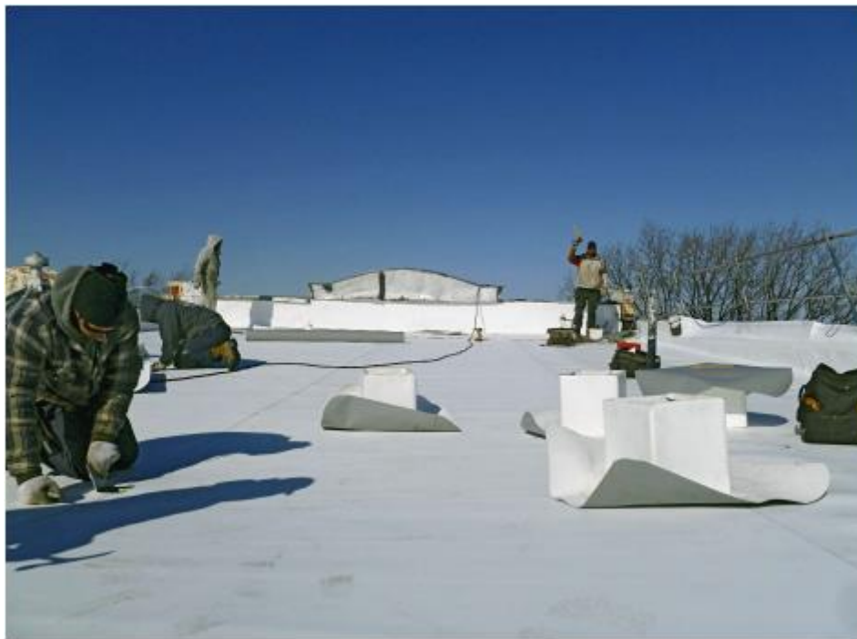
Figure 68 : Photo d'une toiture blanche dans Rosemont. Source : RNC, 2014b 125
