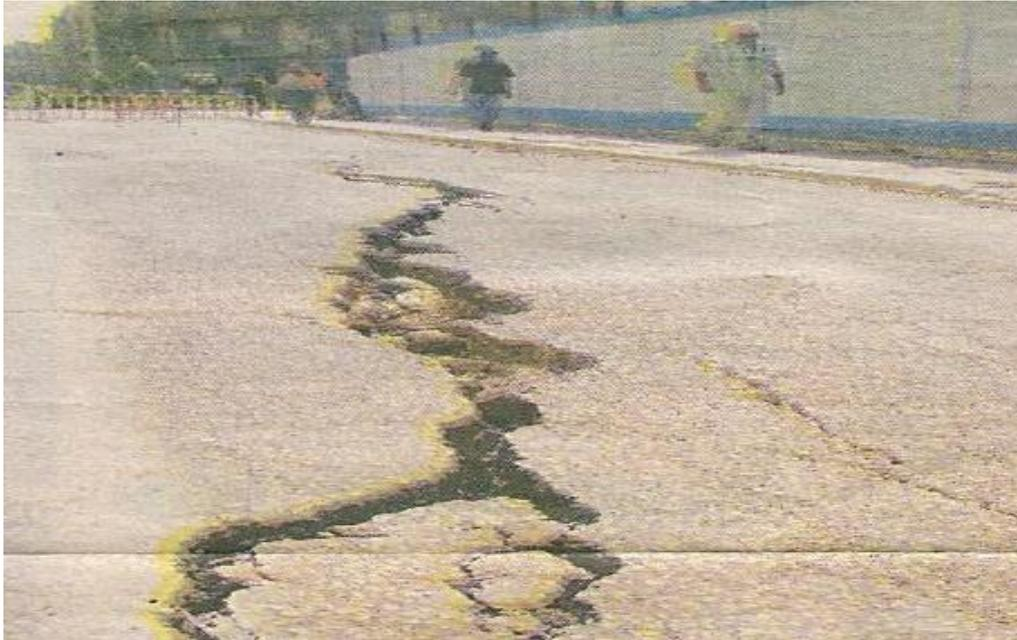
Fig.25- chaussée endommagée par une fissure de plusieurs mètres
