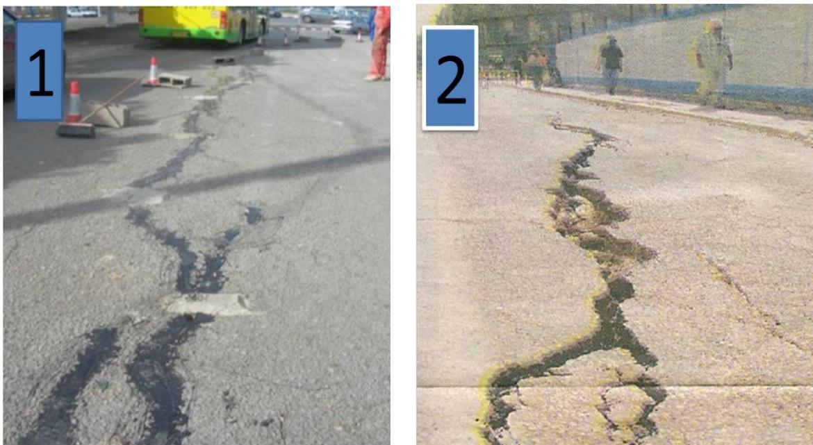
Fig. 24- Fissuration d'un tronçon de l'avenue débouchant sur le pont Zabana
