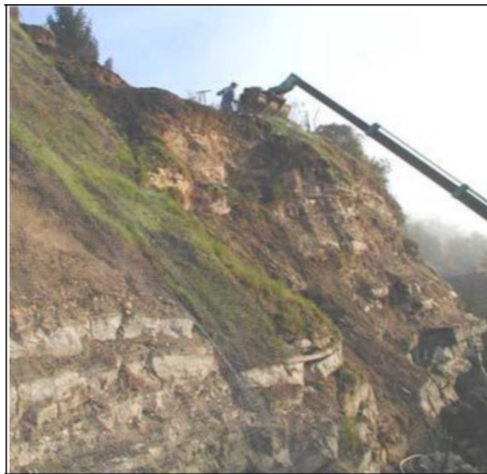
Fig. 49 a - Mise en place d'une Couverture végétale (Conflans Ste-Honorine, Val-d'Oise)
