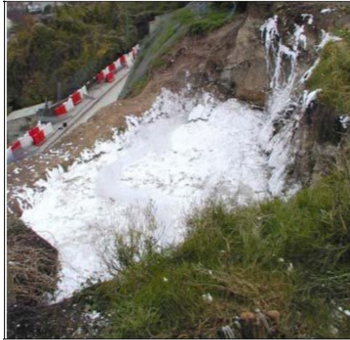
Fig. 49 a - Remplissage d'un fontis par de la mousse thermodurcissable
