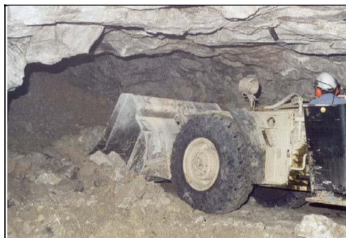
Fig. 45 - Remblaiement direct par le fond avec des engins mécanisés
