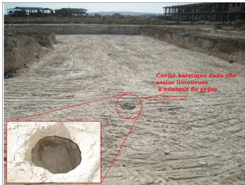
Fig. 17 - Cavité karstique suite à la dissolution du gypse à El Kerma
