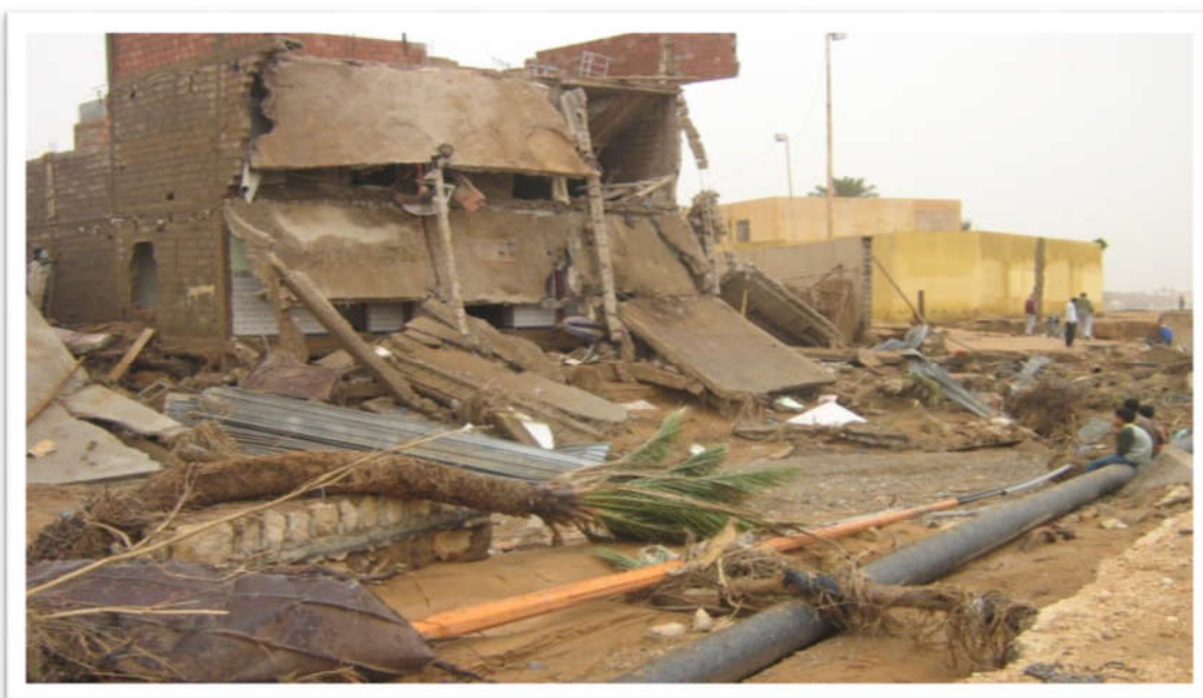
Images N°06 et07 : Dégâts du secteur du logement
