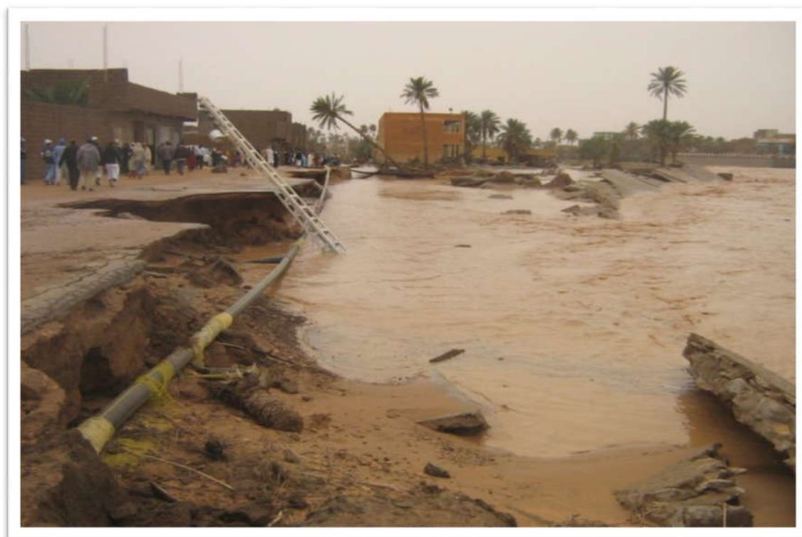
Image N°11 : Dégâts de la crue sur les dévers secteurs
