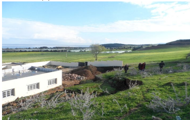
(e) Dégât aux habitations après le glissement
