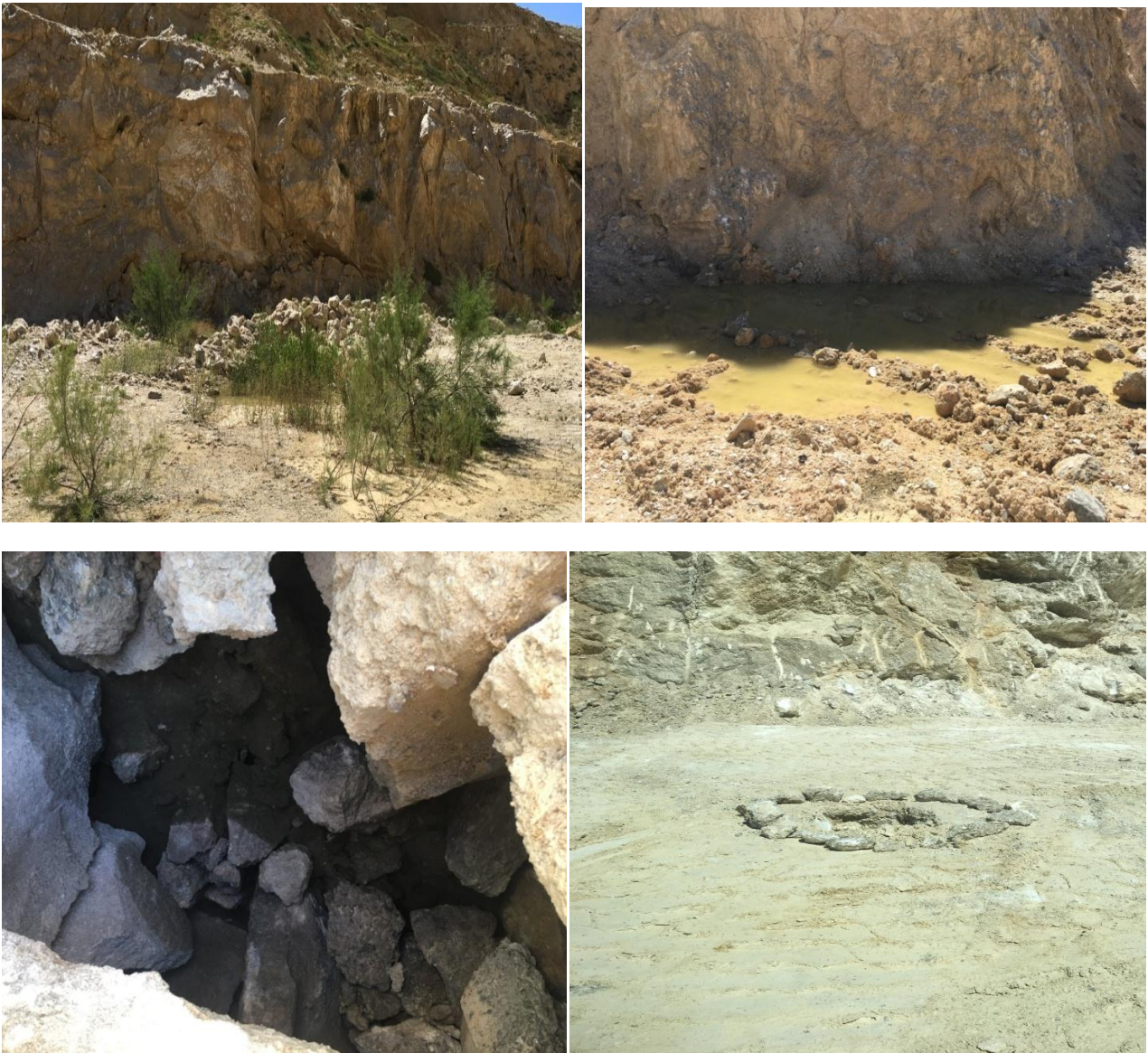
Photo n°11: Remontée des eaux d'une nappe phréatique d'eau saumâtre.
