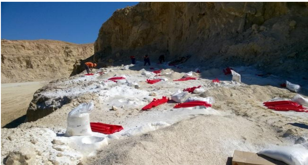
Photo n°09 : le remplissage des trous de mine avec l'anfomil et la marmanite.
