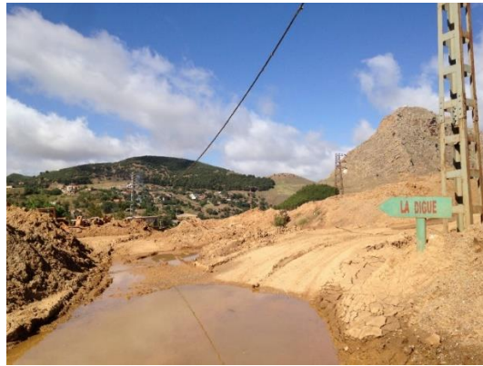
Fig. 29 : Vue de la surface du stockage des stériles à Bou-Caid.
