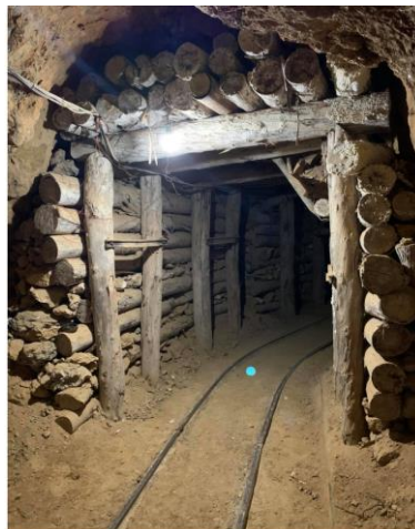
Fig.22 : Soutènement de type espacé boisé.
