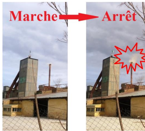
Fig. 30 : Vue du dégagement des poussières avant et après l'arrêt du système de dépoussiérage (KHARFELLAH et SLIMANE, 2016).
