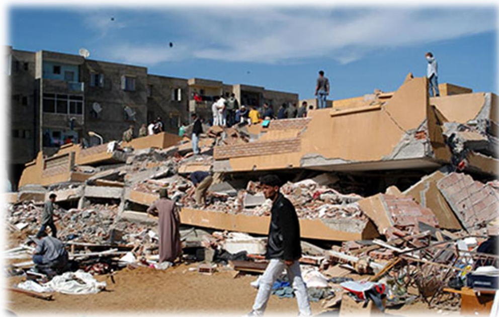
Fig 17 : Le séisme de Boumerdes en 2003 (in www.craag.dz )
