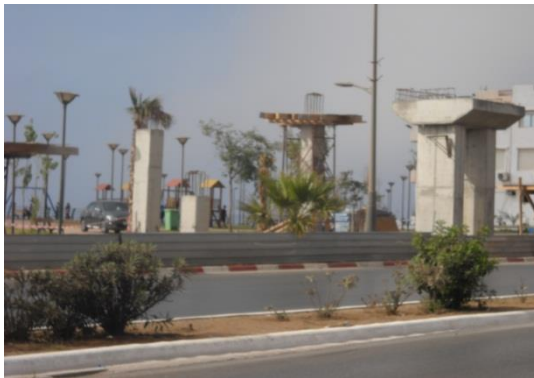
Photo N° 27 : Réalisation d'une passerelle au niveau du jardin Citadin à Oran Source Enquête terrain 2016
