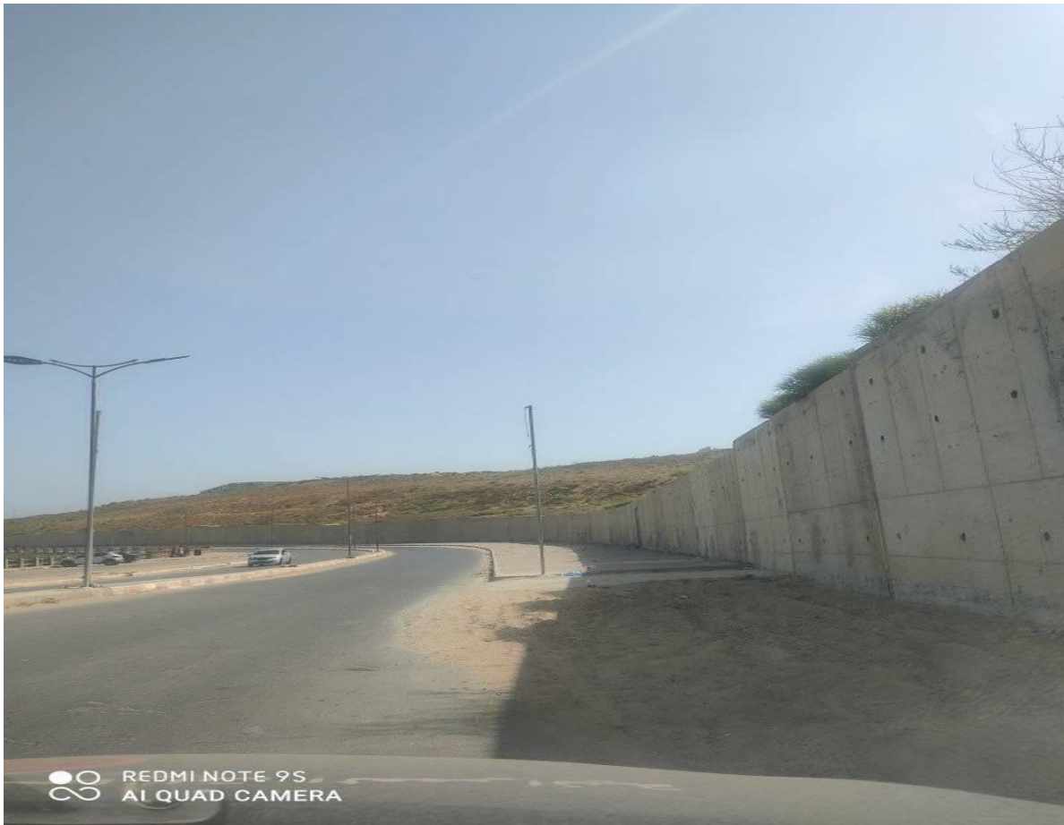
Photo18:le mur de béton en face de plage de sisi Medjdoub
