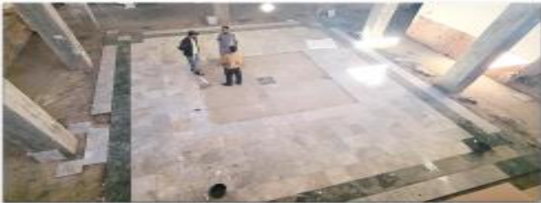
انطلاق اشغال تركيب رخام الرضية في مبنى الاجراءات
