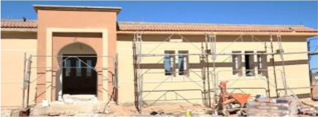
اشغال التلبيس الخارجي النهائي بمادة MONOCOUCHE في الجانب الجزائري
