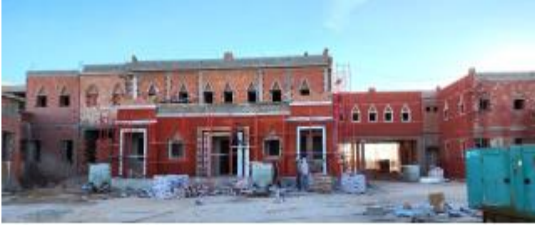
اشغال التلبيس الخارجي النهائي بمادة MONOCOUCHE في الجانب الموريتان
