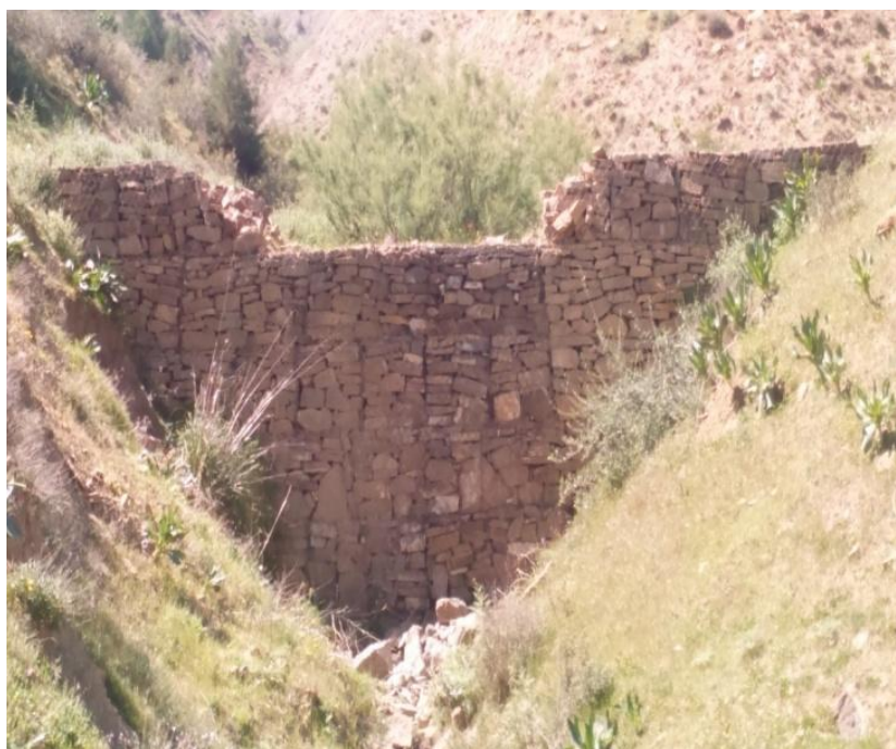
Figure n°16 : seuils en gabion avec déversoir
