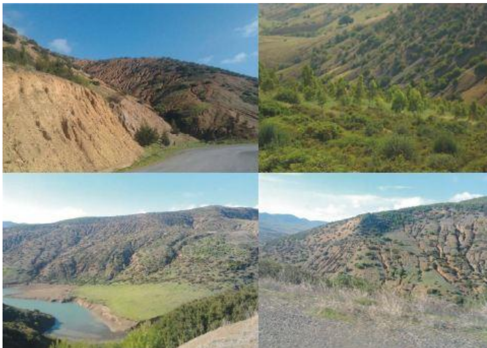
Figure n°28 : Erosion linéaire sur les sols de BV de l'Oued Rhiou
