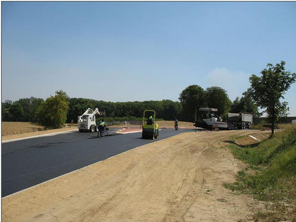
**Photo n°6 : Bitumage d'une chaussée**
