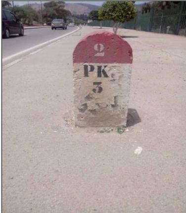
Fig n°15: Borne kilométrique (RN)
