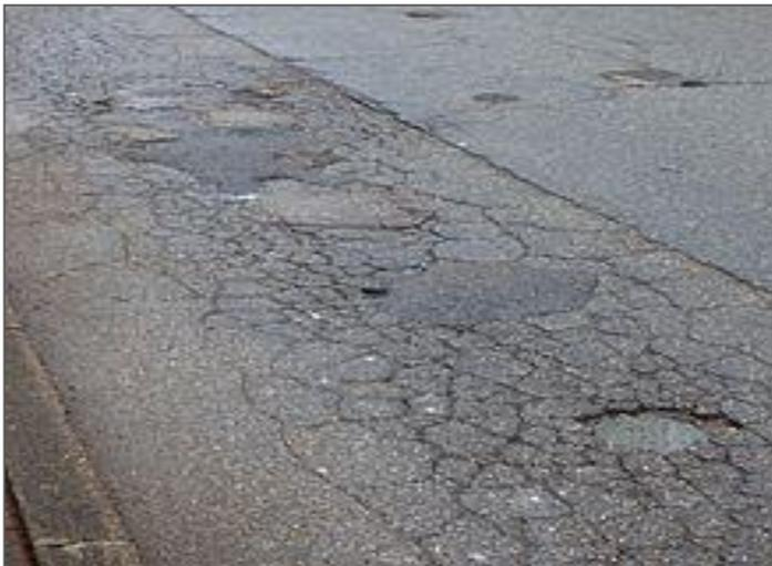
**Photo n° 5 :** Des nids-de-poule partiellement rebouchés à l'aide d'enrobé
