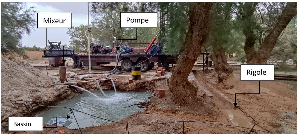
Figure 14 : les bassins et les rigoles (sur chantier)
