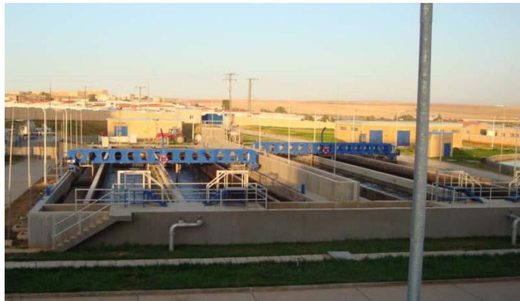
**Fig. n°29: ouvrage de dessablage et déshuilage.**
