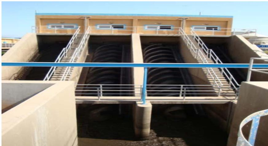
**Fig. n°33 : Vis d'Archimède.**
