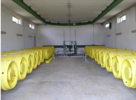
**Fig. n°36: Tank chlore gazeux.**
