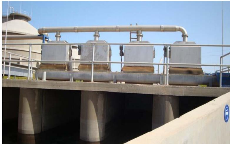
**Fig. n°28 : le dégrillage.**
