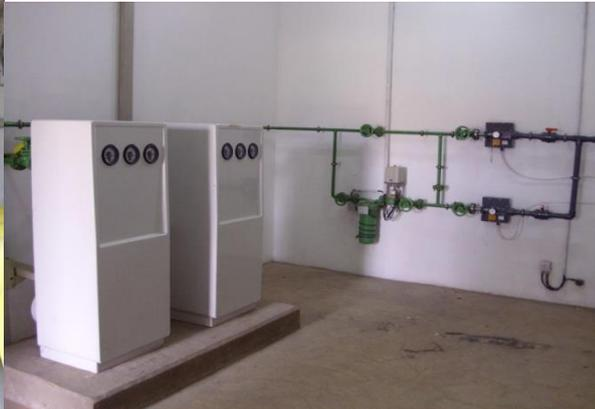
**fig. n°37: Evaporateur de chlore.**
