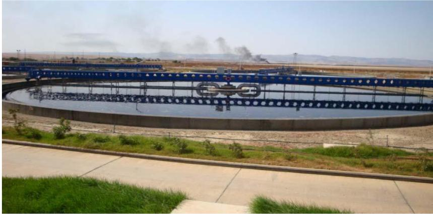
**Fig. n°32 : Bassin de décantation secondaire.**
