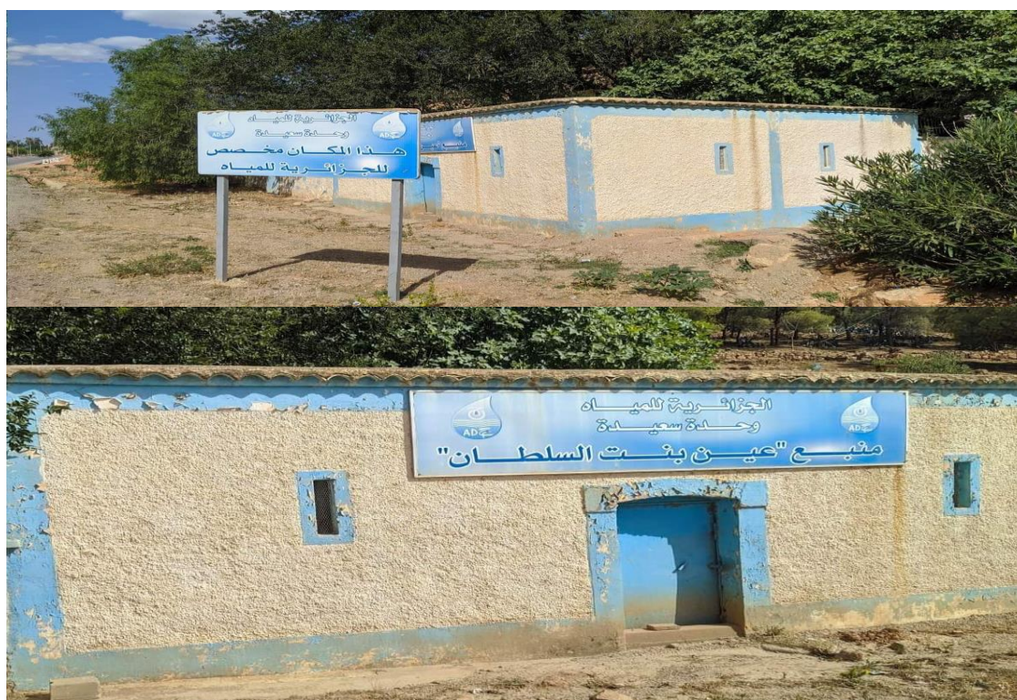
Fig.32: Galerie captant de la source Ain Bent-Soltane (Saida).
