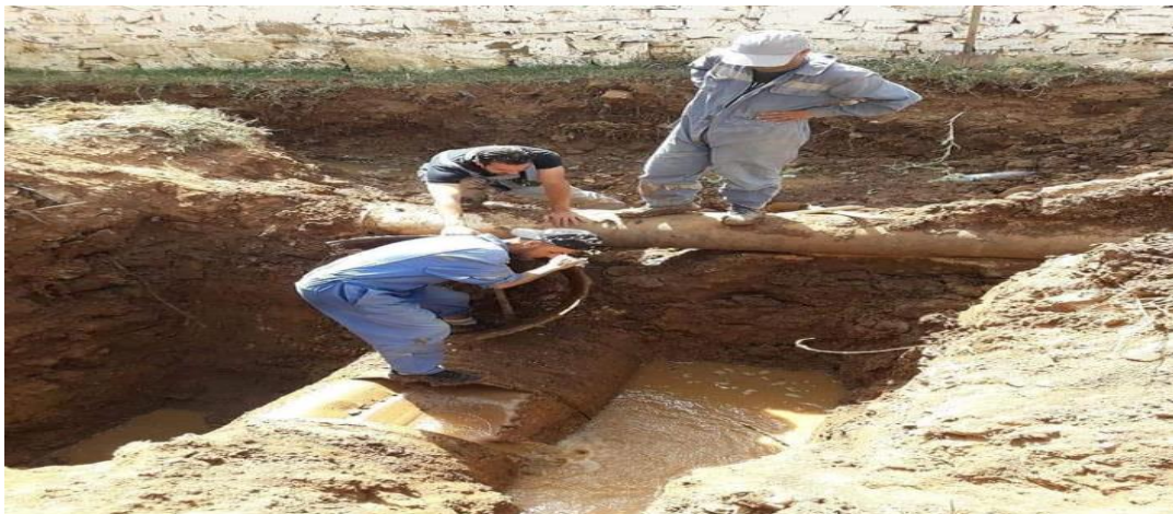
Fig.30 :L'aménagement de la source Ain Bent-Soltane par le système drainant.
