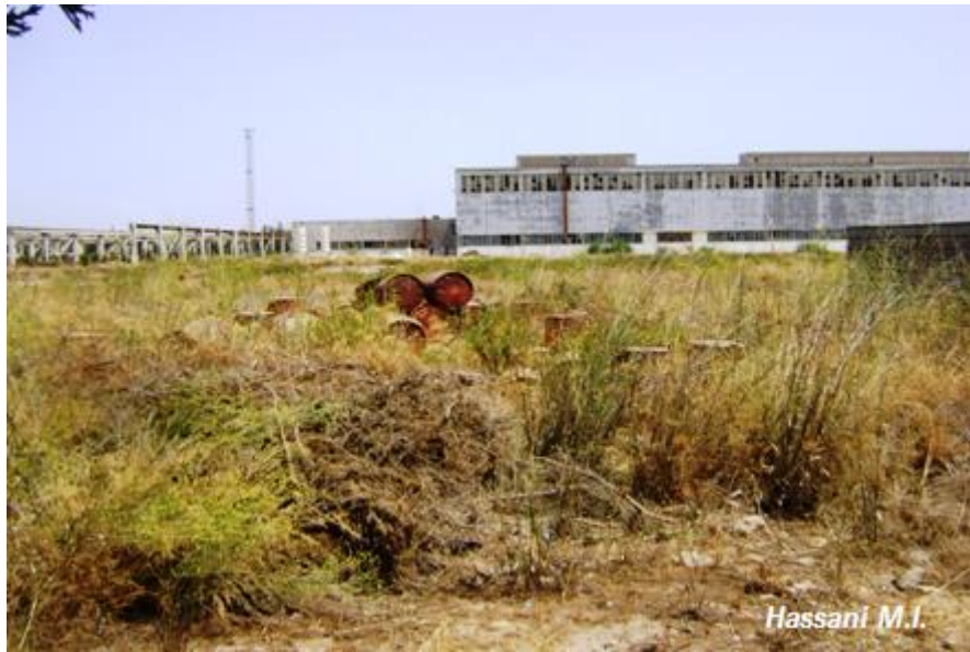
Figure n° 30: Fûts métalliques de déchets stockés à l'intérieur de l'unité SIMAS.
