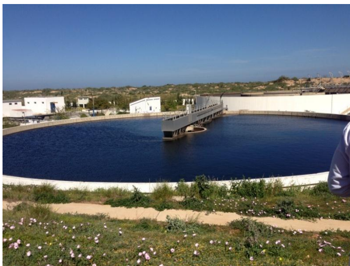
Figure 35 : bassin de Clarification
