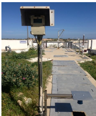
Figure 25 : Débitmètre d'entrée
