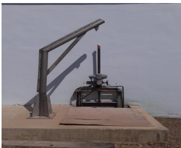
Figure 21 : Piège à cailloux
