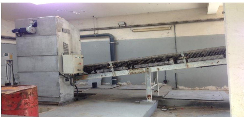
Figure 23 : Dégrilleur fin
