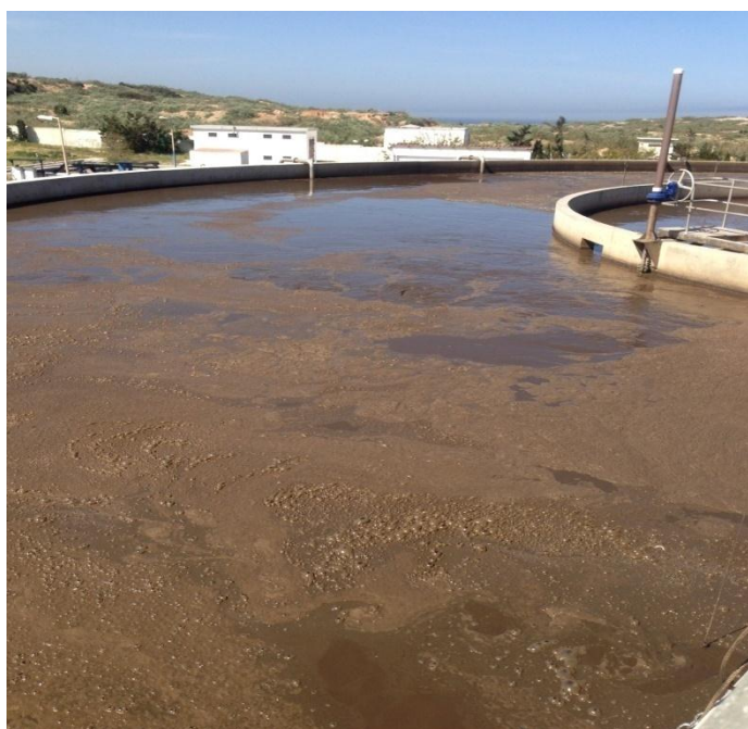
Figure 31 : Zone d'aération
