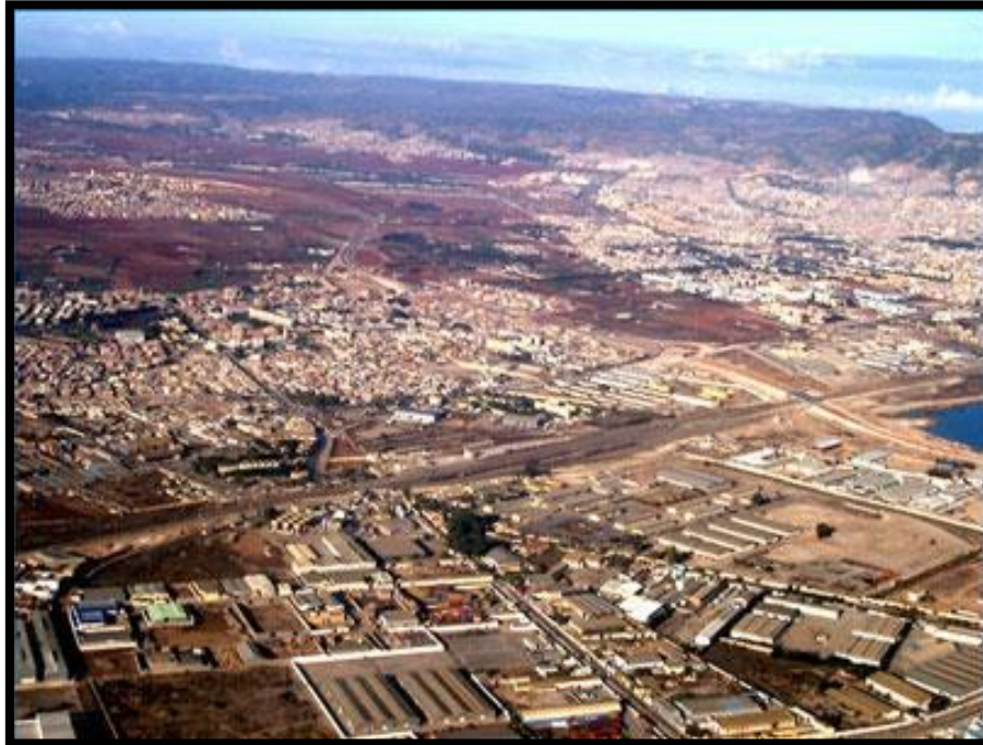
Figure n°20 : Vue aérienne de la zone industrielle de Hassi Ameer
