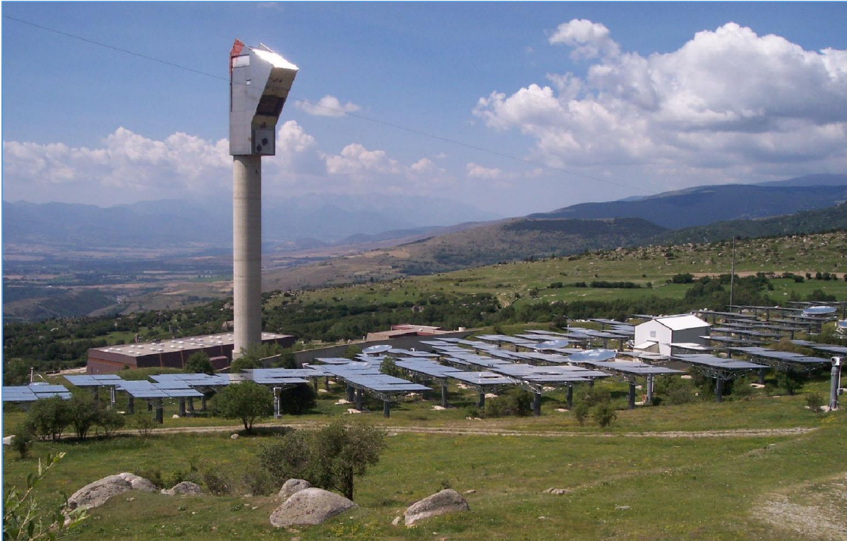
Figure 2.7 : Photo de la centrale Thémis.
