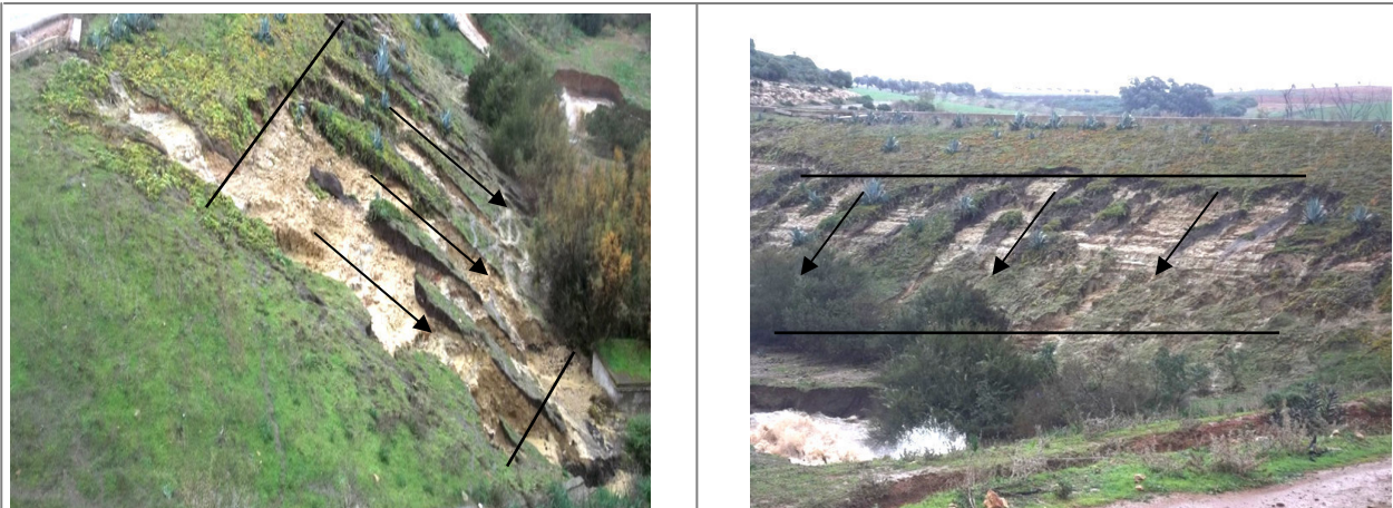
الصورة (29): انجراف التربة على مستوى بعض المنحدرات بالحوض
