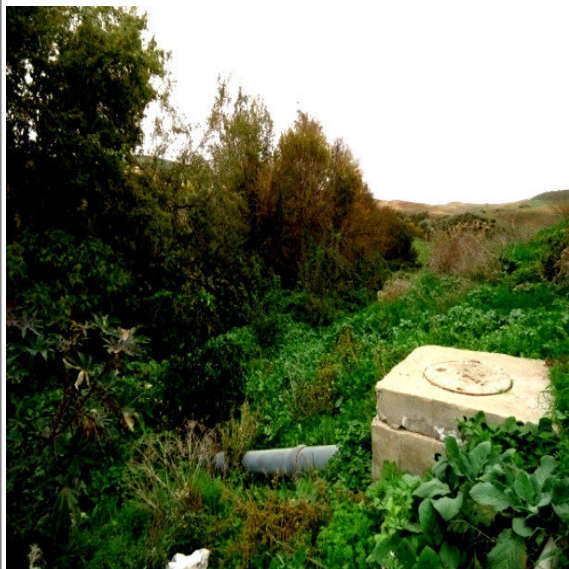
الصورة (21): اشتراك مجموعة من المنازل بشبكة صرف صحي واحدة تتجه مخارجها نحو الأودية مباشرة
