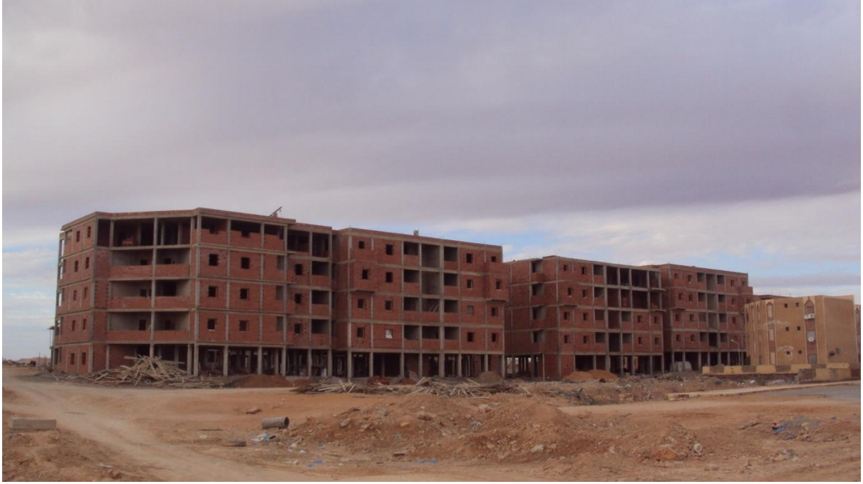
صورة رقم: 25 تواصل أشغال البناء
