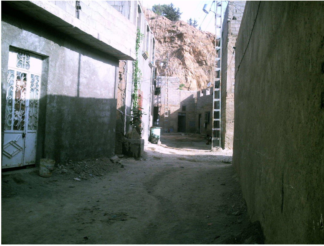
صورة رقم 72: مساكن رديئة في حي المدرجات
