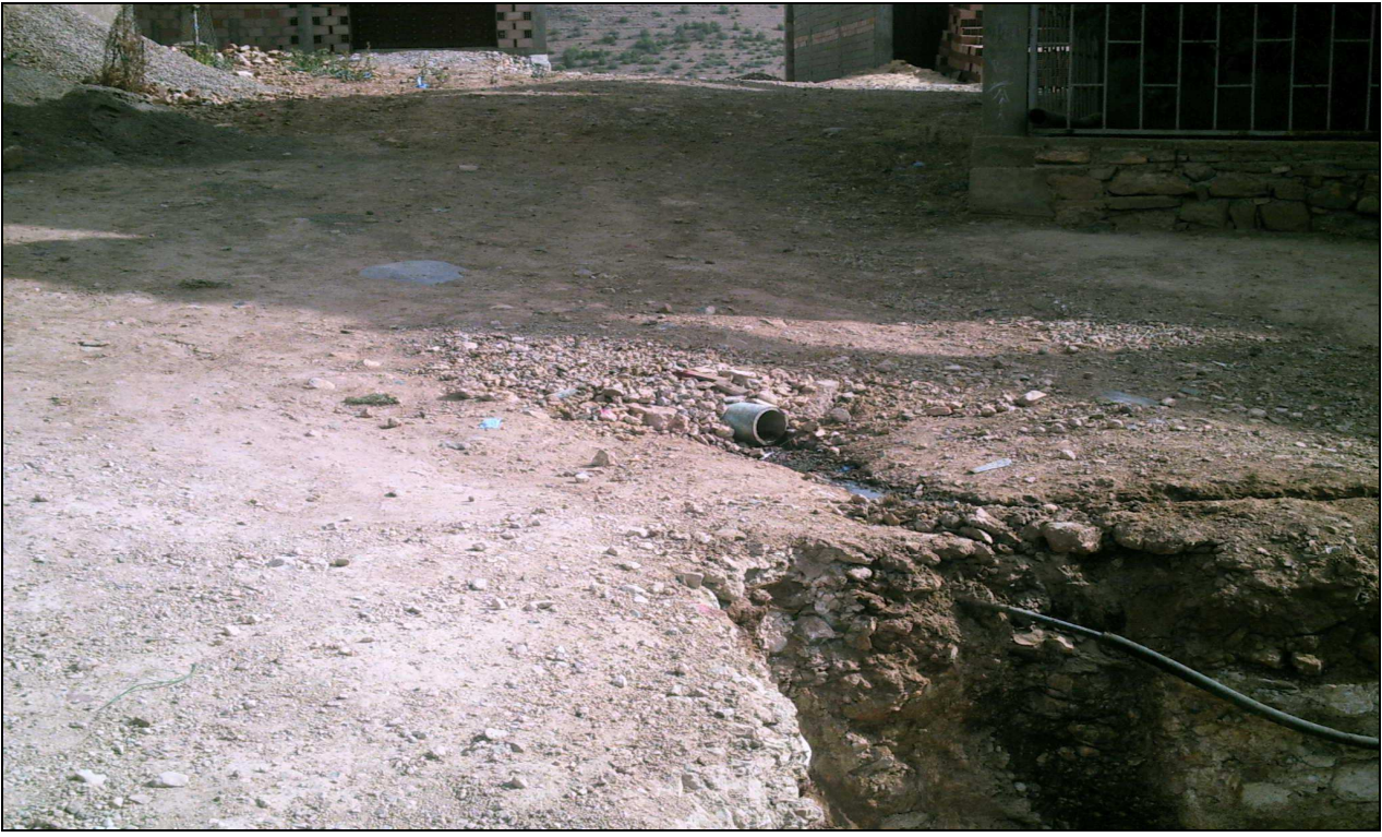
صورة رقم 12: تبين عدم الربط بشبكة الصرف الصحي في شمال حي أولاد بن دامو.
